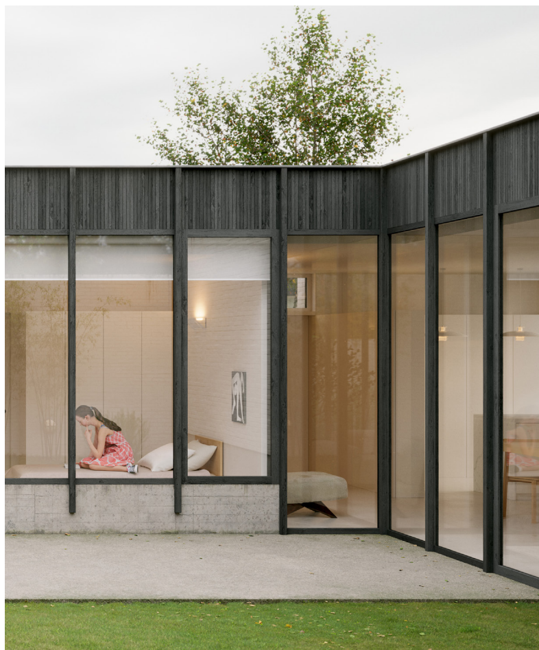
F11. Casa Tipo B, courtyard e zona privada
